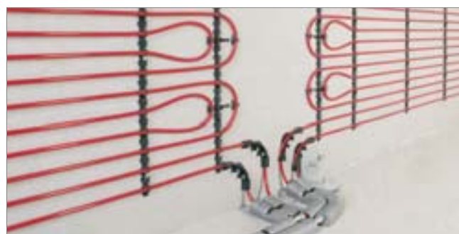
Система настенного отопления/охлаждения («мокрый» способ укладки труб)
