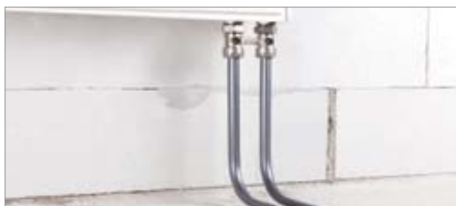
Прямое подключение отопительного прибора трубой RAUTITAN stabil
